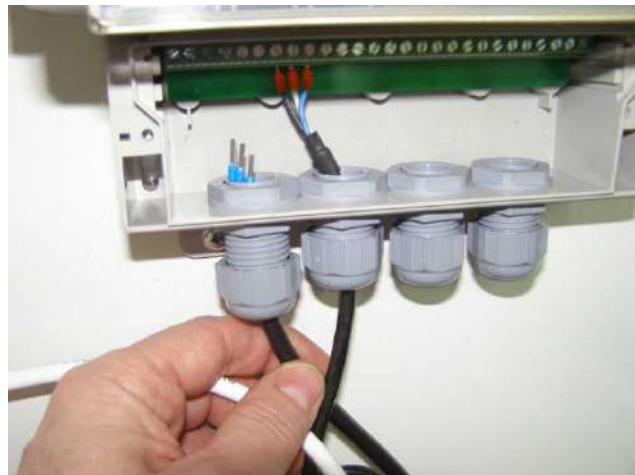
Рисунок Г.1 - Отсоединение кабеля датчика
