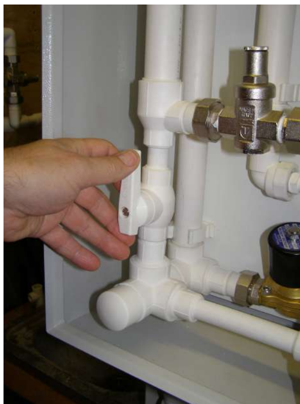
Рисунок 16 - Очистка трубы отстоя
