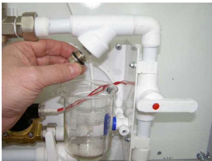
в) отвернуть заглушку фильтра, подставив сосуд для стекания остатков воды (не более 200 мл)
