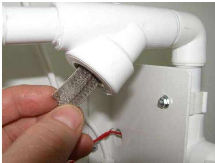
г) вынуть и промыть сетку фильтра
